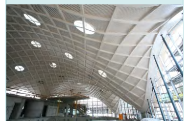
Holzschalenkonstruktion Fontana Terme Bad Orb
