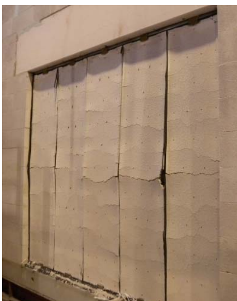
Beflammte Seite der Revisionsöffnungsverschlüsse nach einer Beflammungsdauer von 60 Minuten
