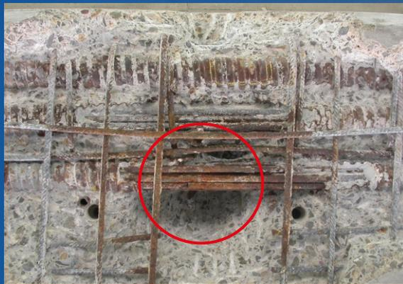
Geöffnetes Hüllrohr mit Spannstahlbruch in einer Spannbetonbrücke
