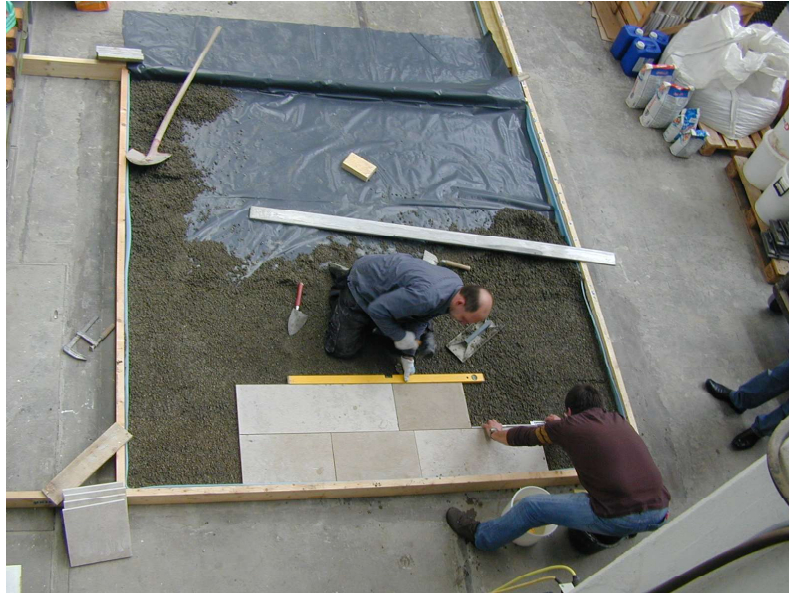
Bild 5: Herstellung eines Bodenprüfkörpers (Monokornestrich 3 m x 3 m)
