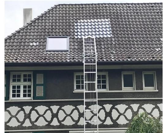
Musterfeld auf dem Dach mit 50 solarhybriden thermisch und elektrisch aktivierten Dachsteinen
