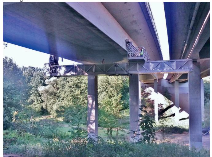
Abbildung 3: Brückenuntersuchung mit der magnetischen Streufeldmessung
