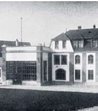
Neubau der Materialprüfungsanstalt (1907)
