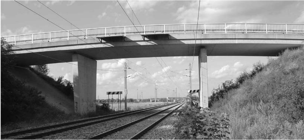
Bild 5-3. Ansicht der Überführung über die Bahnstrecke Wien - Laa, aus [8]
