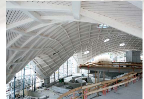
Bauwerksuntersuchungen und -berechnungen an komplexen (Brettschicht-) Holzkonstruktionen
